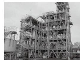
写真1 プラント全景
