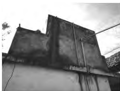
地下水中のヒ素ろ過装置
