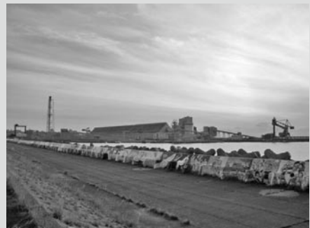
写真2 能代火力発電所を臨む「はまなす画廊」
