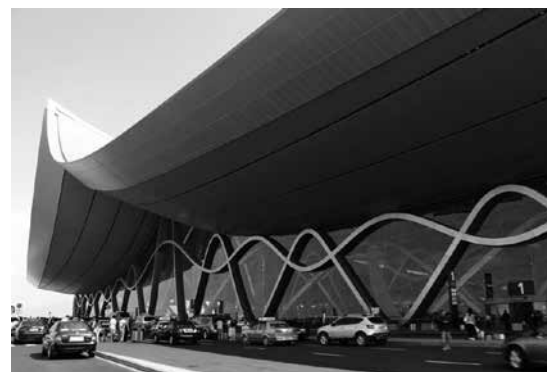
写真2: 昆明の新空港
