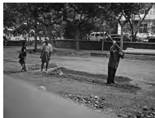
写真8: 人力が活躍する道路工事の様子
