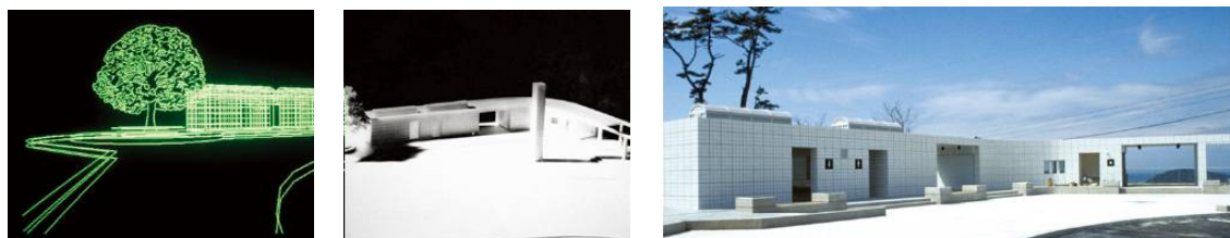
図 4-14 門崎駐車場整備事業（左；CG 画像、中；模型 右；完成後写真）
