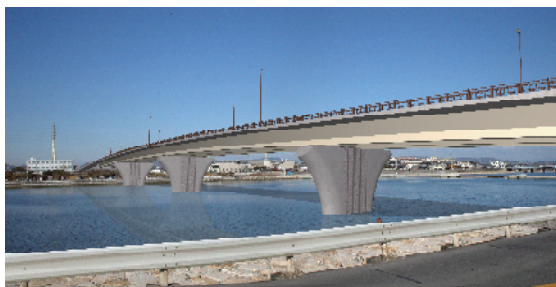
図4-26 市川大橋 全体図 （提供；株長大）
