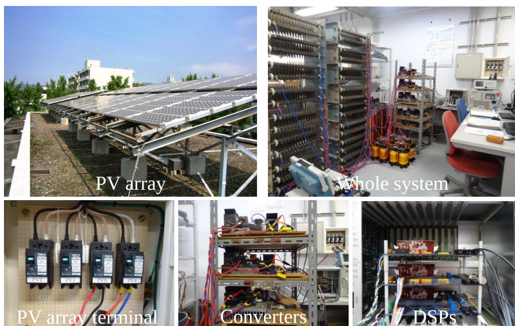
図 5.18 システム設置の様子
