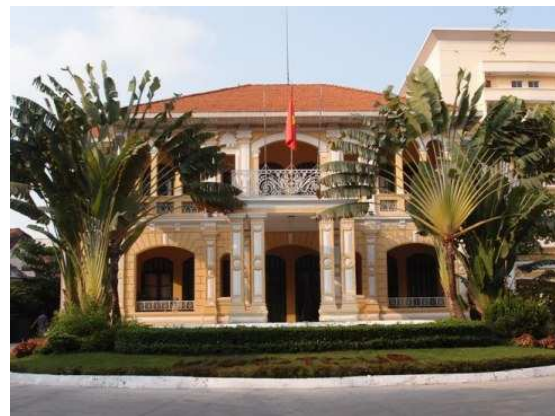
写真 2.3.25 歴史的重要な建築物として指定されているビラ住宅 (3)
