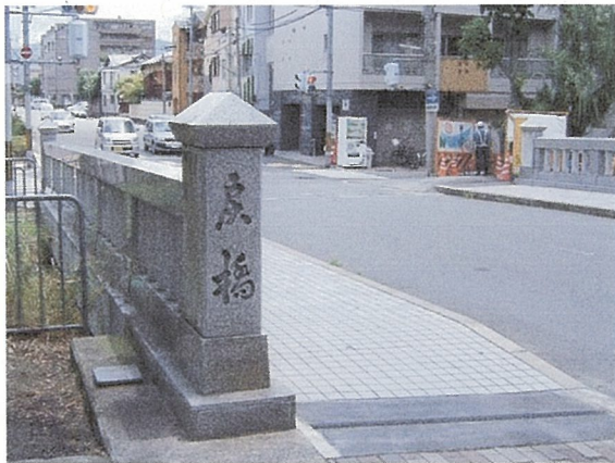
(図2) 現在の一条戻り橋 21
