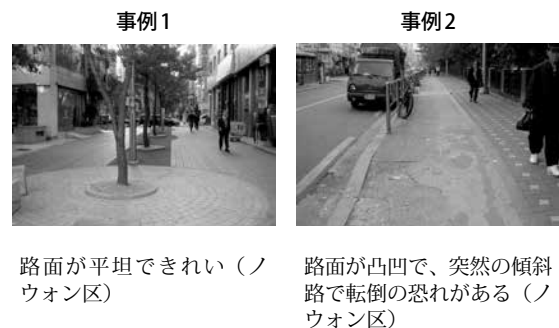
図2. 歩道の仕上げ状況
