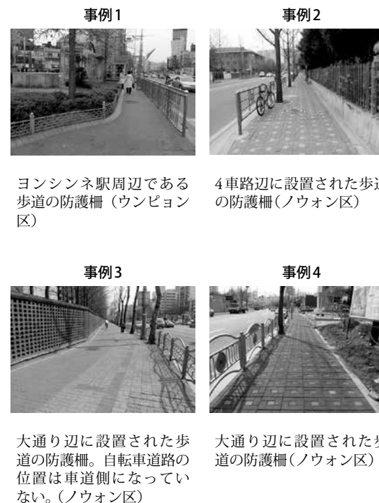
図11. 歩道の防護柵
