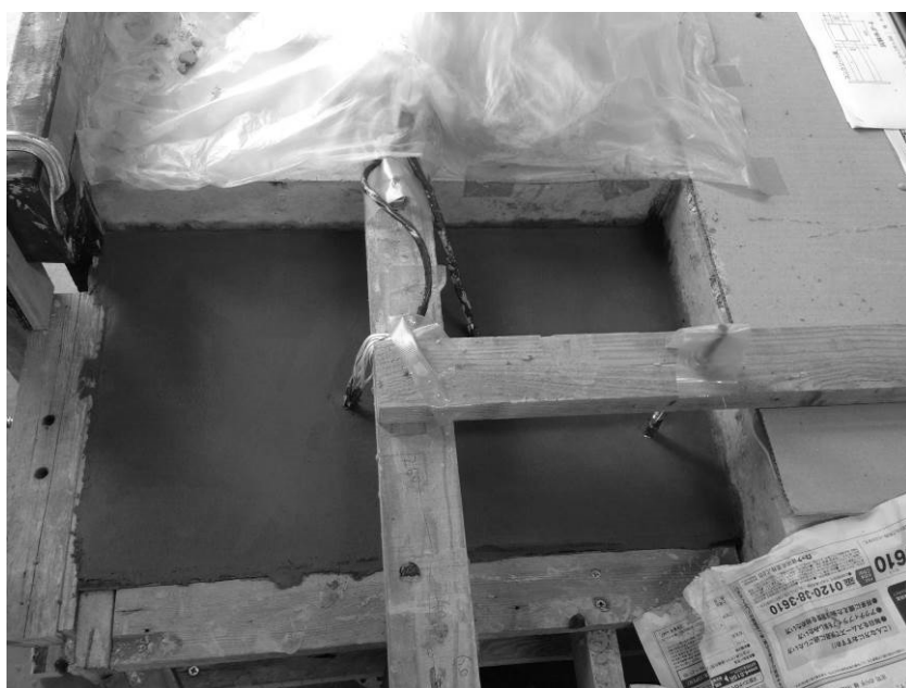
(f) コンクリート打設
