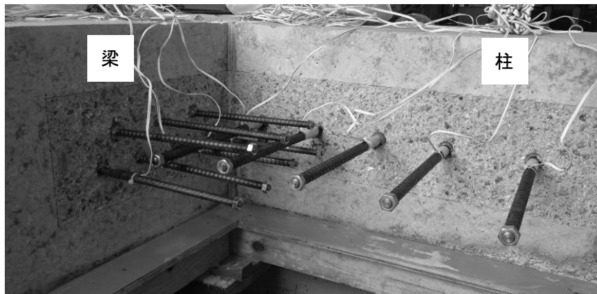
(d) アンカーの設置
