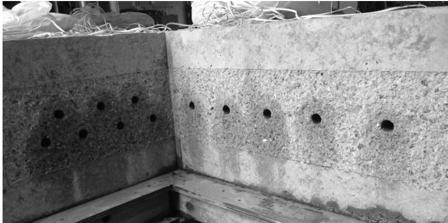
(c) 接合面の目荒し，アンカー穴
