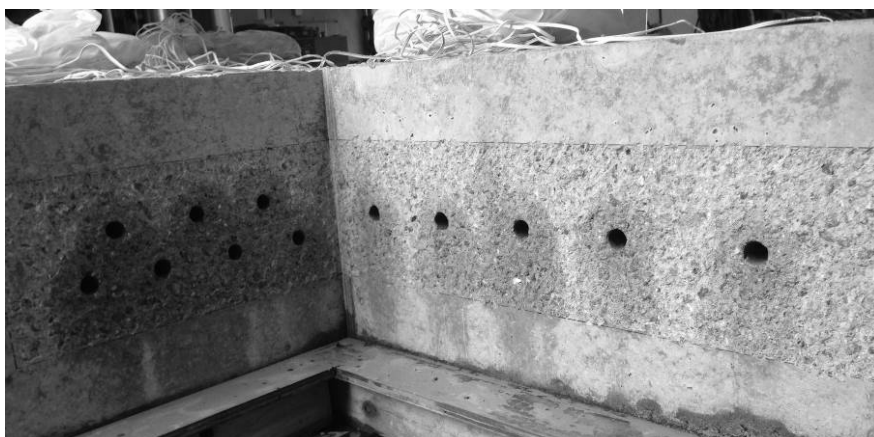
(c) 接合面の目荒し，アンカー穴
