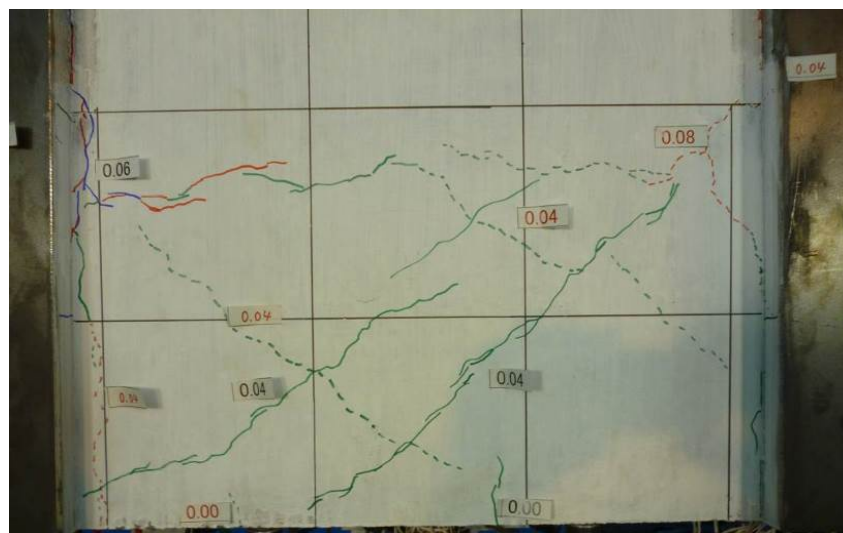
(b) 接合部パネルの拡大写真
