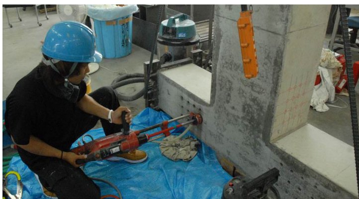
(a) あと施工アンカーの穴あけ作業
