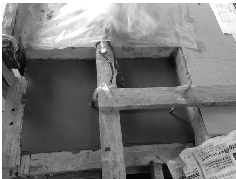
(f) コンクリート打設
