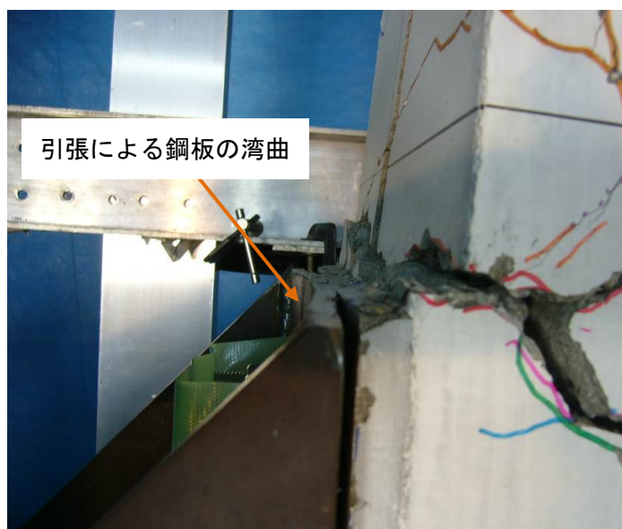
(a) 引張側デバイスの損傷
