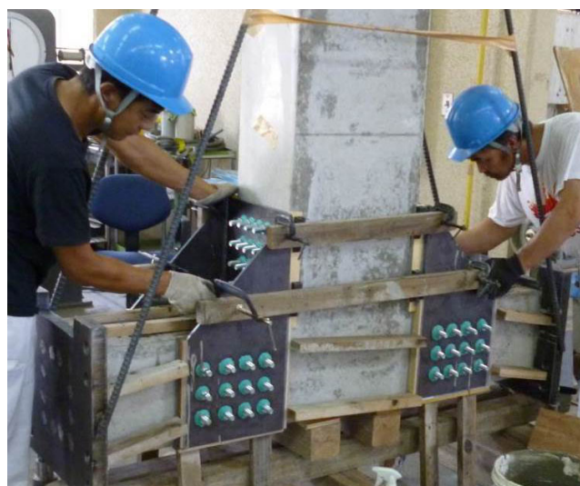
(c) デバイスと既存部の隙間へのグラウト材の注入
