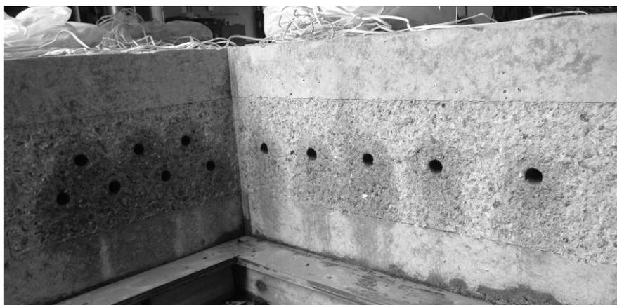
(c) 接合面の目荒し，アンカー穴
