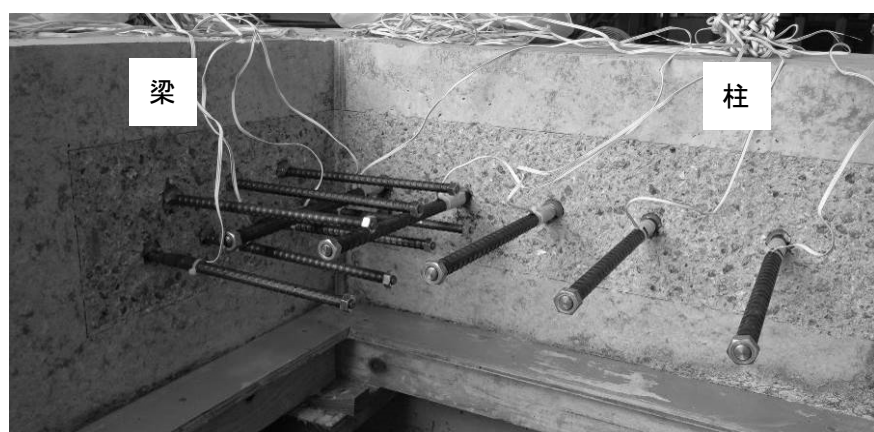
(d) アンカーの設置
