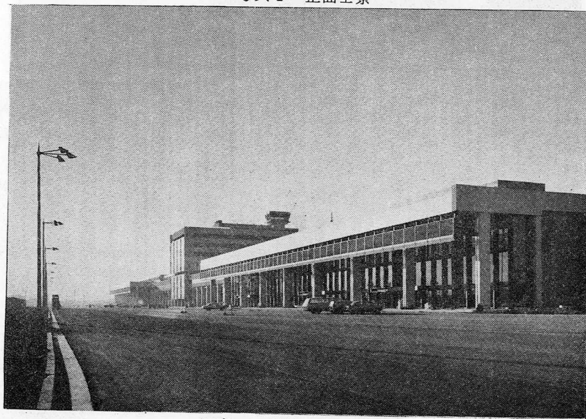
写真2 道路側外観，車寄せ
