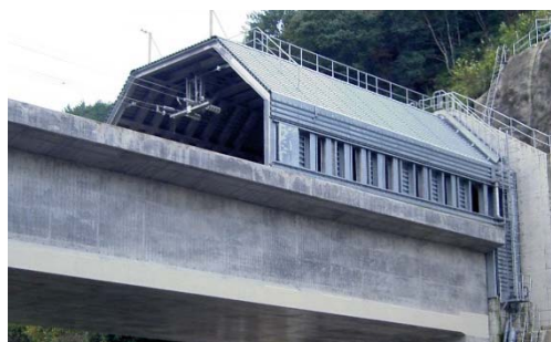
図4. 2 トンネル入口緩衝工
