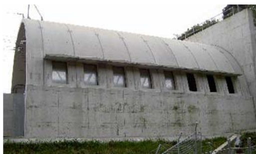
図4. 2 トンネル入口緩衝工
