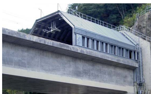
図4. 2 トンネル入口緩衝工
