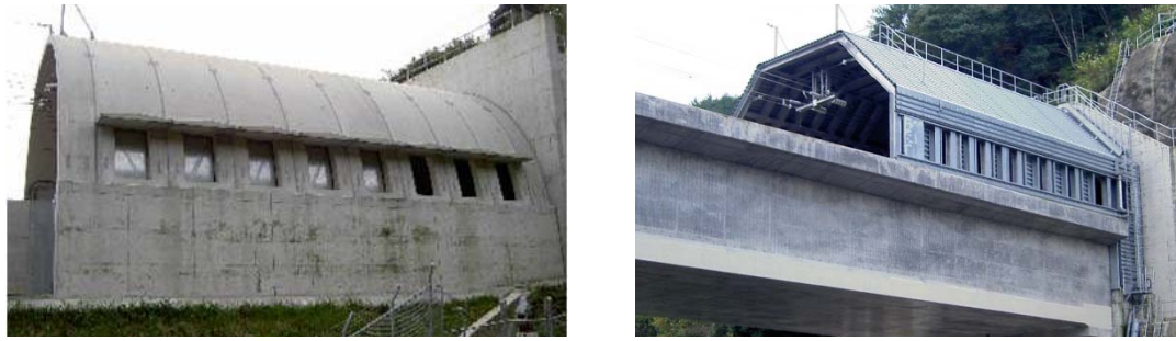
図4. 2 トンネル入口緩衝工
