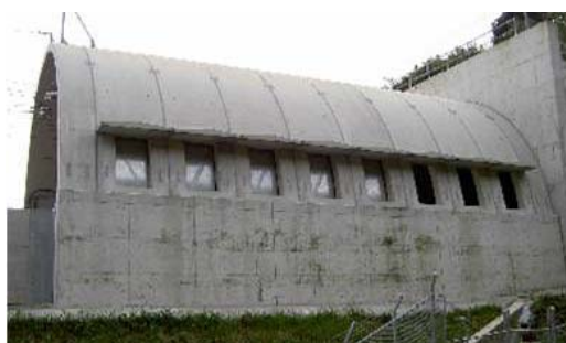
図4. 2 トンネル入口緩衝工
