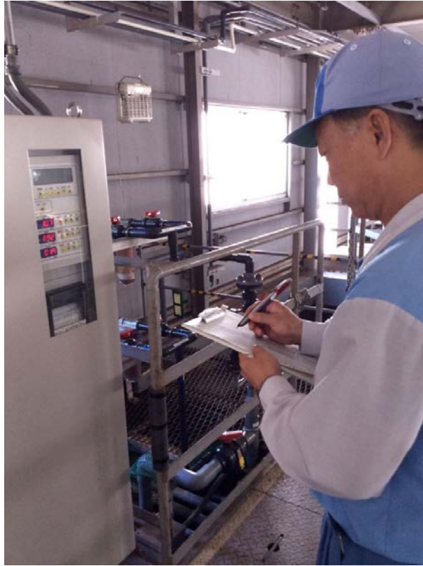
図 4.12 現場での保全作業風景
