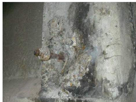
(b) PC鋼棒の突出事例
