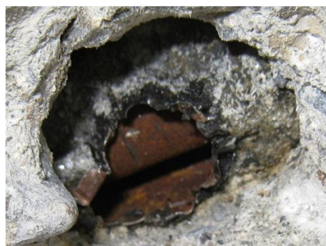
(a) グラウト充填不足によるPC鋼棒の腐食
