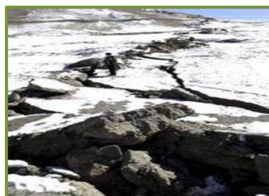
写真 1.1.1 凍結地盤の地震被害
