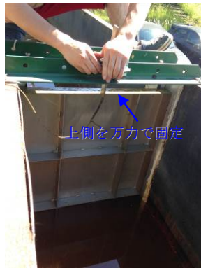
(c) ゲート閉鎖時の状況
