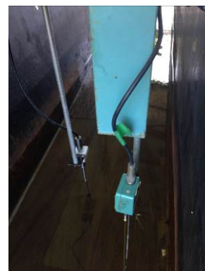
(f) 沖側の容量式波高計(H1)と電磁流速計の設置状況
