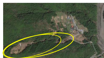
写真3 山天の土砂崩れ google2016
