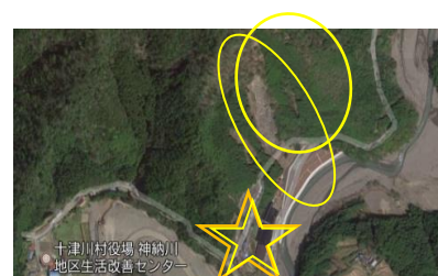
写真2 県道733号線沿いの土砂崩れ google2016
