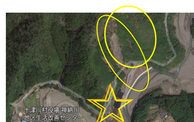
写真2 県道733号線沿いの土砂崩れ google2016
