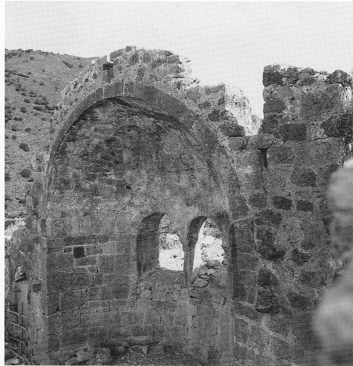
Fig. 30. Church II, Gemiler Ada. Apse.
