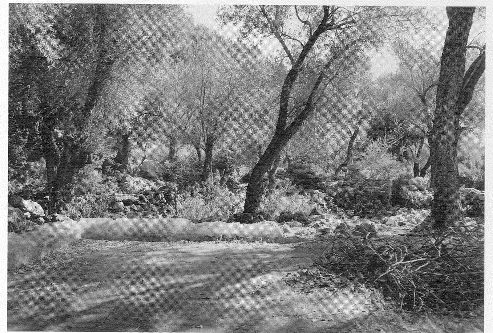
Fig. 80. Ölüdeniz Lagoon Basilica. Cistern.
