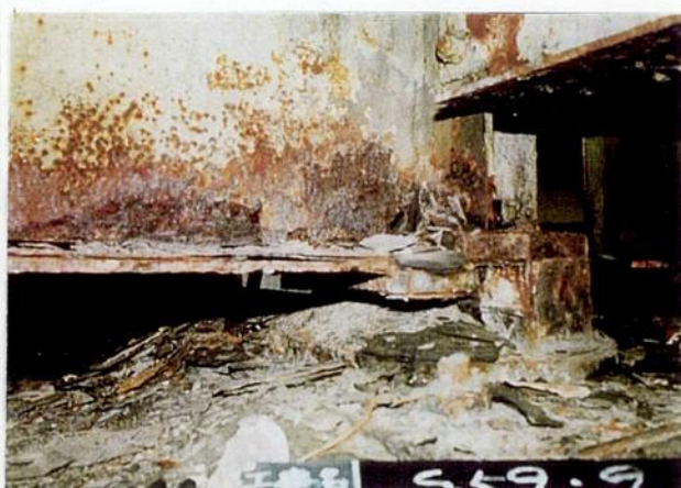
(b) 支承付近
