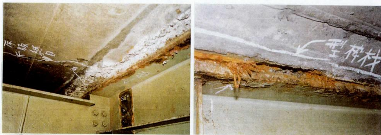
(b) 存置型枠材からの漏水
