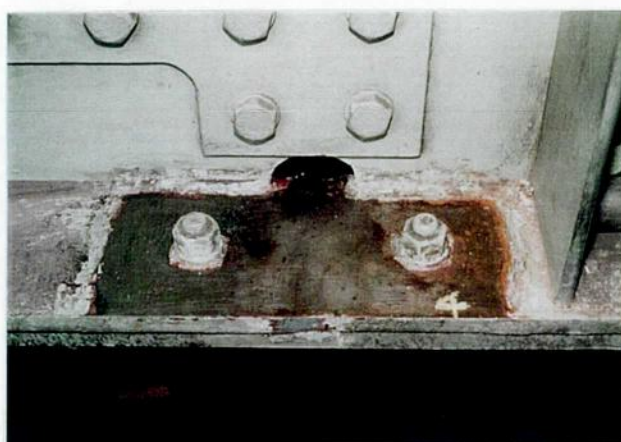
写真－4. 3. 5 溶接部非破壊試験状況
