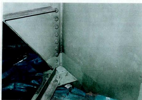
写真－5. 2. 2 補修状況
