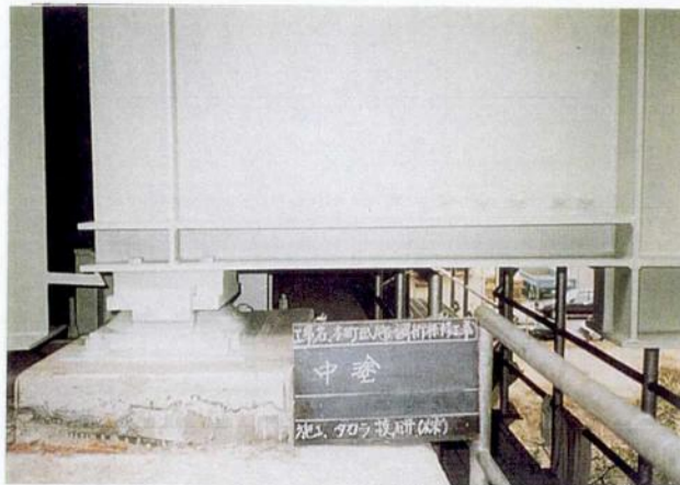
写真－４．２．３ 桁端部腐食損傷補修後の状況
