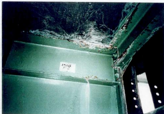
写真－４．２．５ 補修箇所の上部および床版
