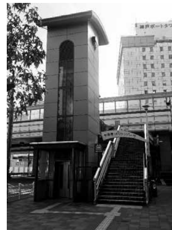
写真3. 国道2号を横断する歩道橋
