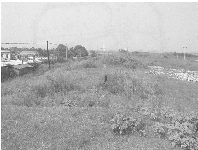
写真②：紀南城南城壁の突出部（東から西に向かって撮影）
