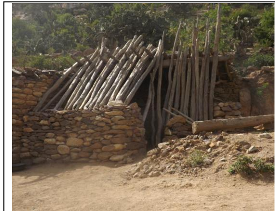
Fig. 4: Hut extension in nahsa (Subiraso Village)
