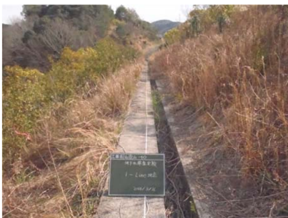
写真 4.3.1 測線（小段方向）
