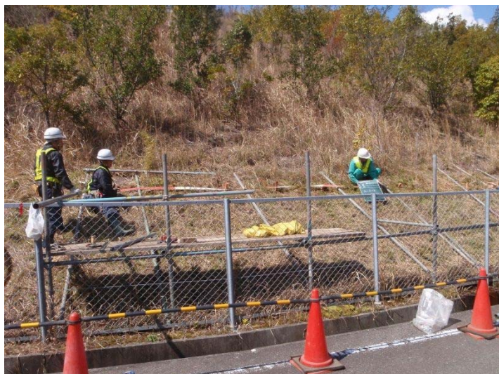
写真-4.2.6 打設位置確認
