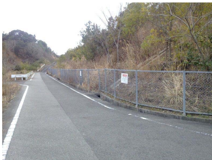
写真-4.2.2 対象盛土 全景
