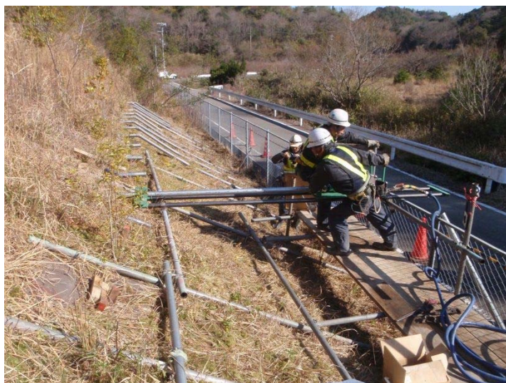
写真-4.2.8 排水パイプ打設状況
