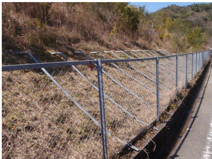
写真-4. 2. 10 排水パイプ打設施工後
