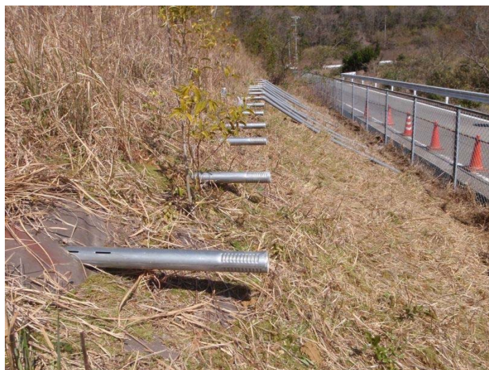
写真-1.1.2 排水パイプ設置状況
