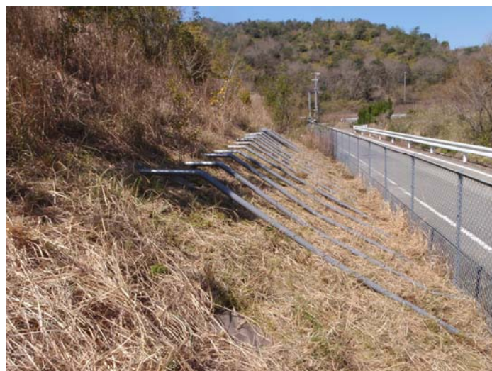
写真-4.1.1 排水パイプ試験施工
