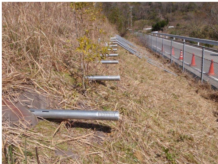
写真-4. 2. 9 排水パイプ打設完了
