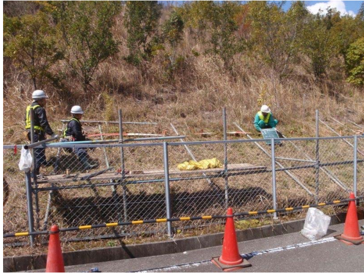
写真-4.2.6 打設位置確認
