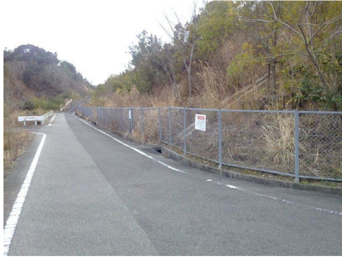
写真-4.2.2 対象盛土 全景
