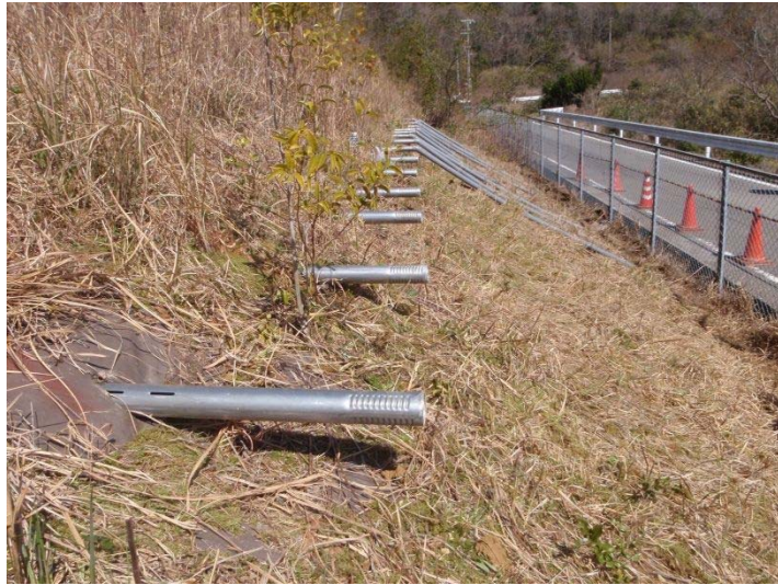
写真-4.2.9 排水パイプ打設完了
