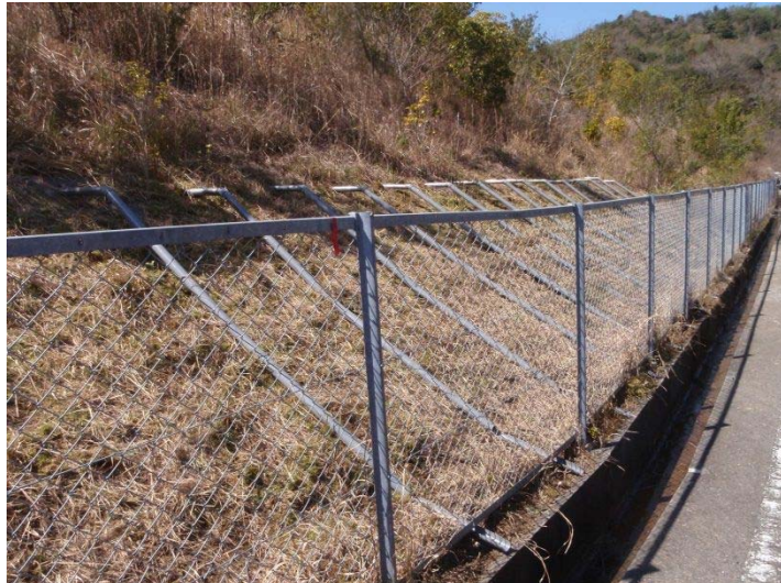
写真-4.2.10 排水パイプ打設施工後
