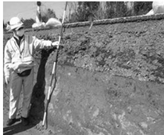
写真-2.2.2 対象盛土の天端変位量 22)
