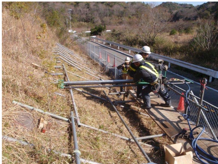
写真-4.2.8 排水パイプ打設状況
