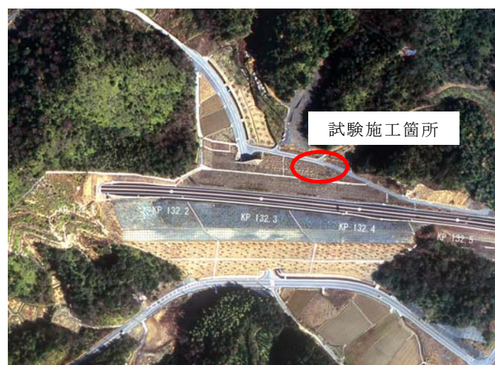
写真-4.2.1 対象盛土 航空写真 (出典：西日本高速道路(株))
