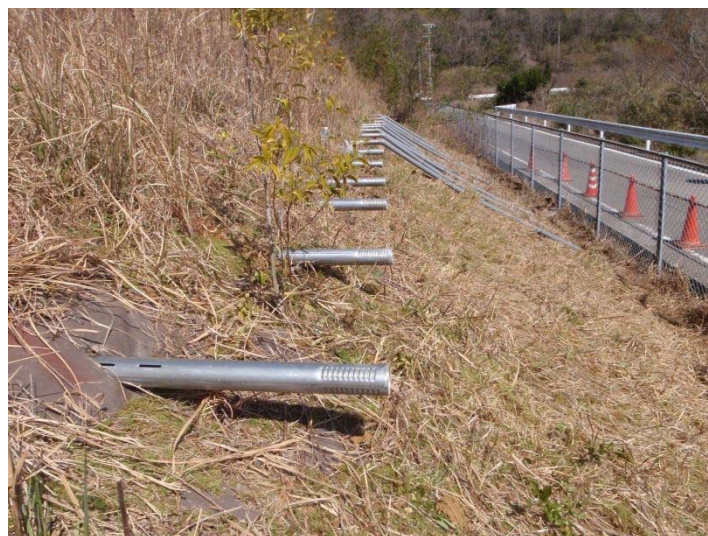
写真-1.1.2 排水パイプ設置状況
