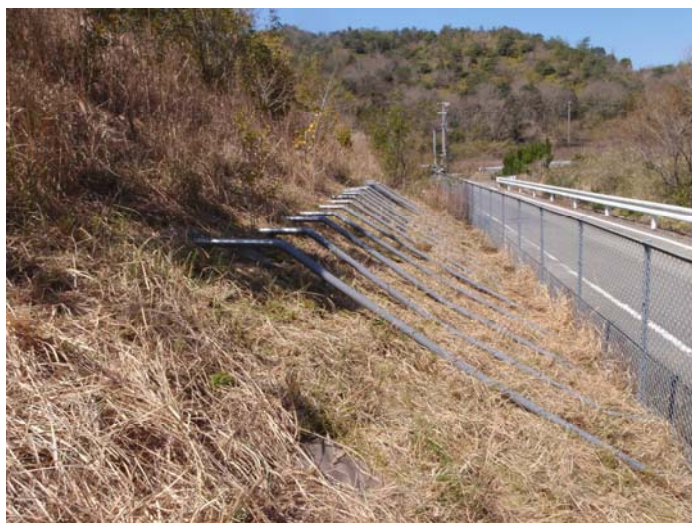
写真-4.1.1 排水パイプ試験施工
