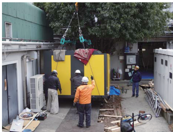
図5: 今回の更新で一番の重量物であるヘリウム液化用圧縮機を搬入する様子。オレンジ色のジャケットを着て中央で指示を出しているのが頭領。
