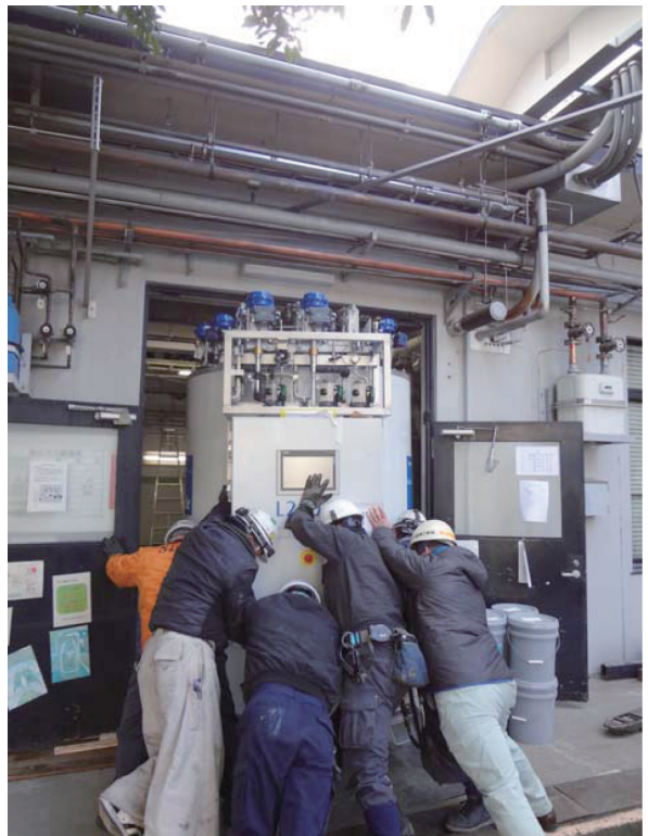
図7: 「せ〜の・そお〜れ」と声を掛け合いながら横にずらして搬入されるヘリウム液化装置。
