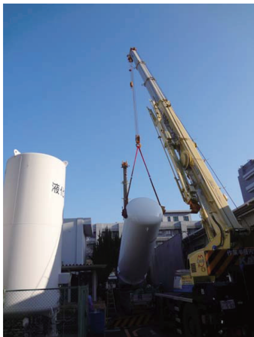
図4: 2台の25 tラフターで吊り上げられるヘリウム中圧タンク。
