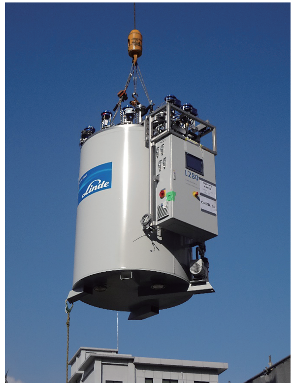
図6: 空飛ぶヘリウム液化装置。ラフターで吊り上げられ、ヘリウム液化室前まで運ばれる新しい液化装置。晴天で良かった。
