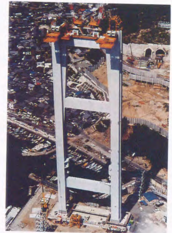
写真5.1 下津井瀬戸大橋 タワーリンクの設置状況
