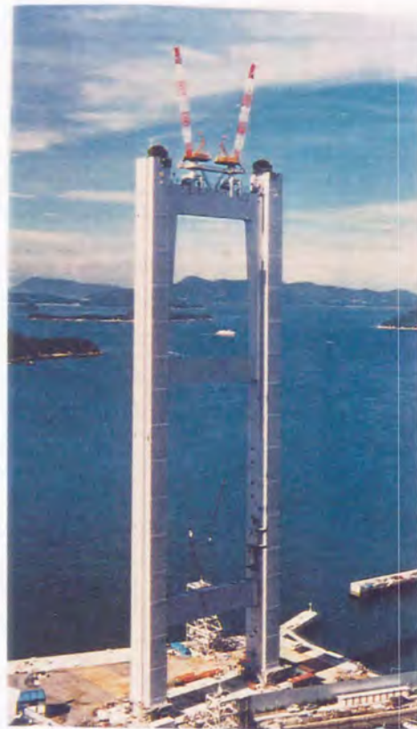
写真5.8 塔完成状況 (SBタワーリンク架設済)
