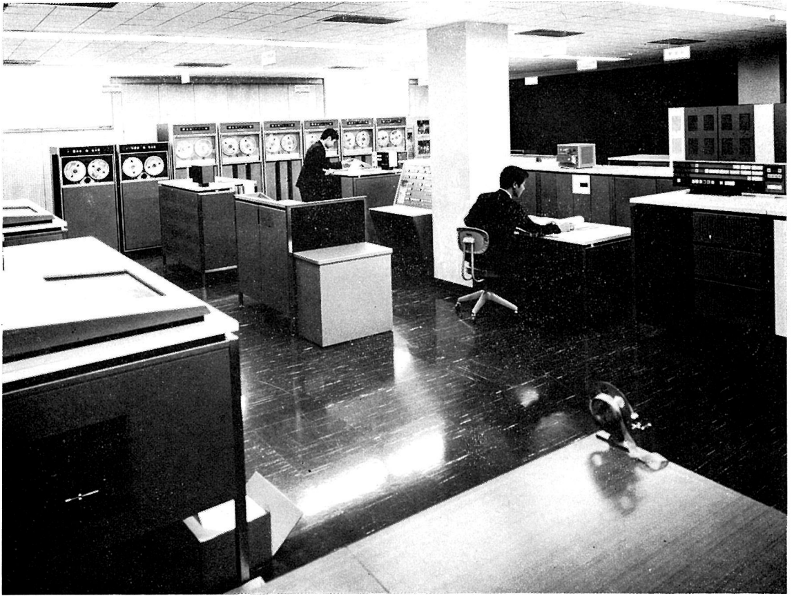
計 算 機 室 内 部
