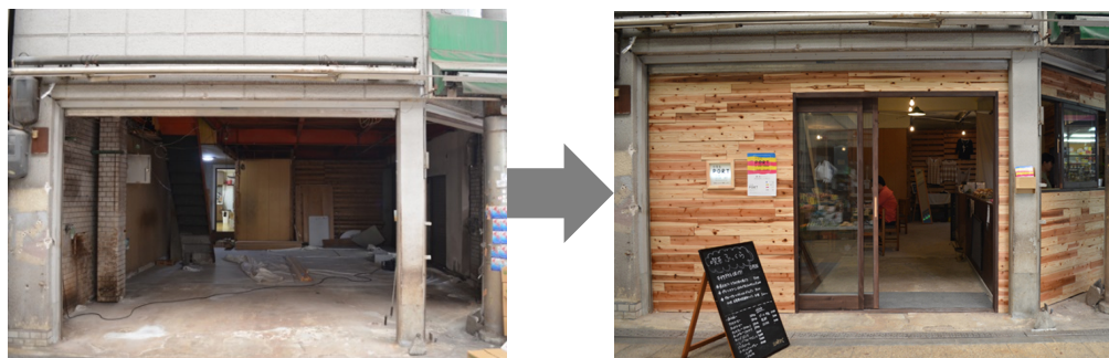
図 3-6 「四貫島 PORT」の改修事例
