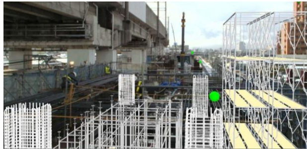
(c) 足場設置
