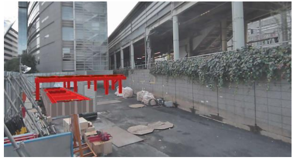
(b) 施工段階 1
