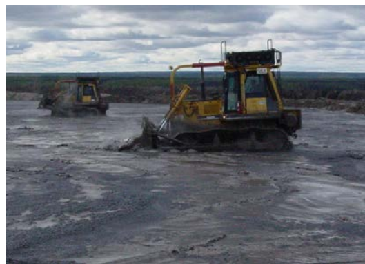
(d) Leveling of sand in muddy tailpond.
