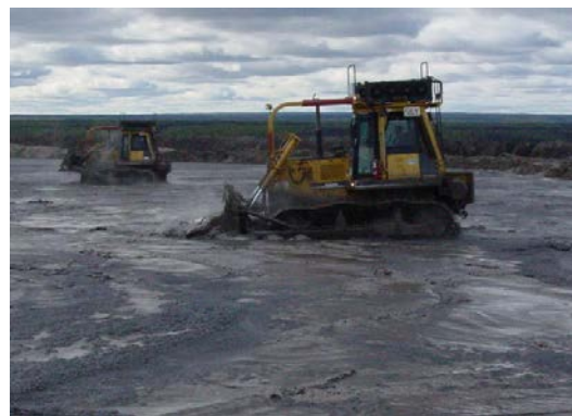
(d) Leveling of sand in muddy tailpond.
