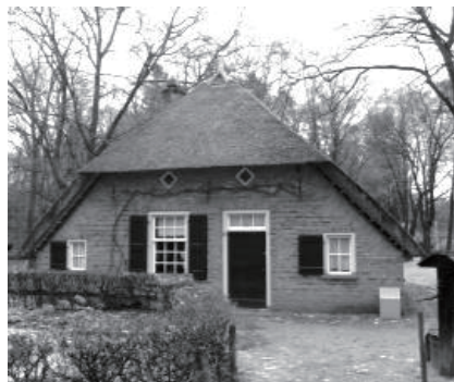
図 11. 煉瓦壁と板壁の併用例
