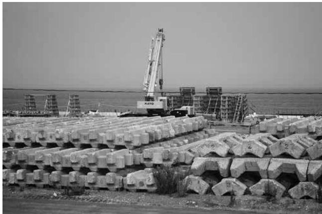
写真1. 野田村・東北コミュニティ・ラーニング2日目 建設中の防潮堤、2015年8月(出典：著者撮影)
