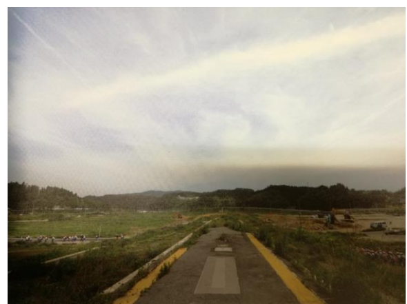
図3. 志津川駅のプラットホーム（佐藤, 2017）
