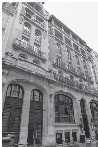
図 11：旧女子電話交換手寮の建物 現在
