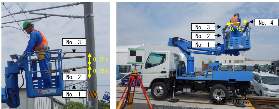
図- 3.12 高所作業車のかごと模擬支障物の配置
