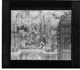
図5 AN.0690 3-7「描かれた壁装飾, ルネサンス, ドイツ, リューネブルク市庁舎」
