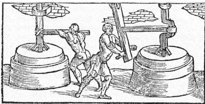
図1 鉱石粒と水銀の混合中にアマルガム化する臼引き装置(Biringuccio 2005 : 385)
