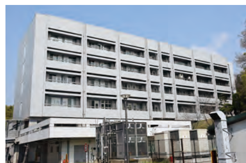
インキュベーション棟 全景
