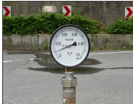
図-6.3.6 注入圧管理状況の事例
