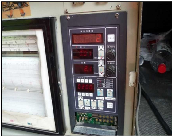
図-6.3.5 注入量管理状況の事例
