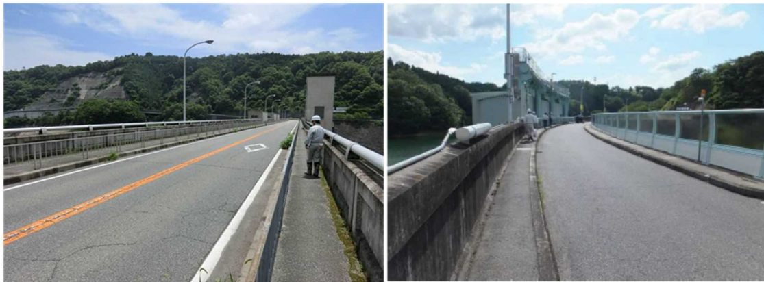
(a) Bダム堤体天端のアスファルト舗装
