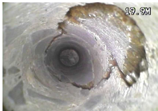
図-3.4.8 堤体上流面からのボーリング孔の孔壁画像
