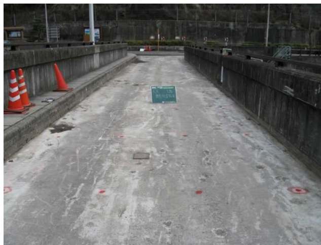
図-4.7.4 アスファルト舗装が撤去されたコンクリートダム堤体天端の状況
