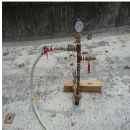
天端注入孔からの注入状況
