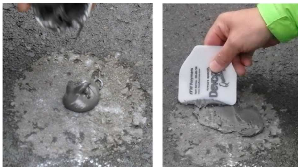
金属補修剤の塗布（舗装面の補強）状況
