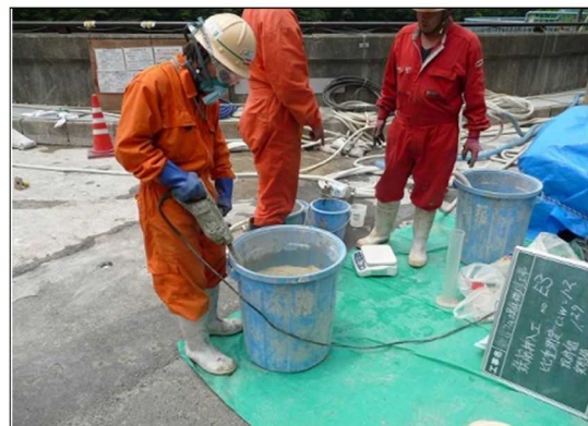
図-6.3.4 注入材の混合の状況例
