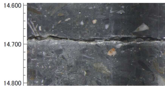
図-3.4.7 ボーリング孔の孔壁画像 (不連続面(14.69m)付近)
