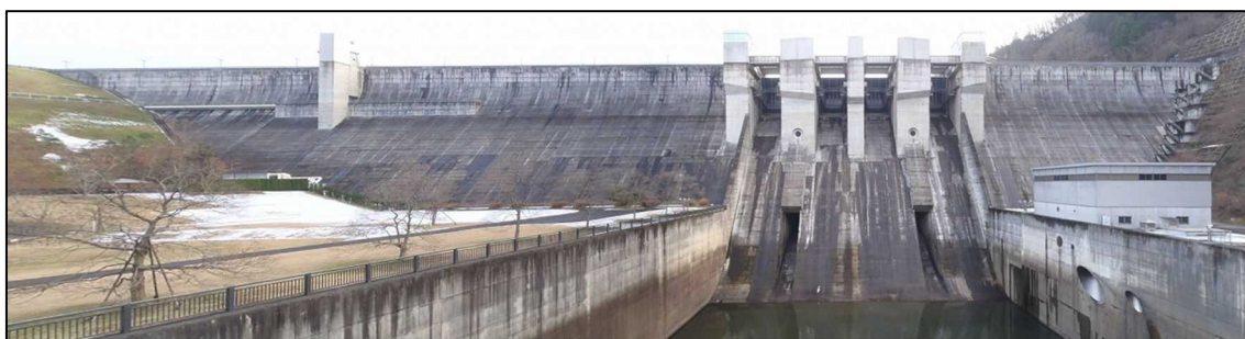
図-3.3.14 堤体下流面の漏水状況(2012年12月)
