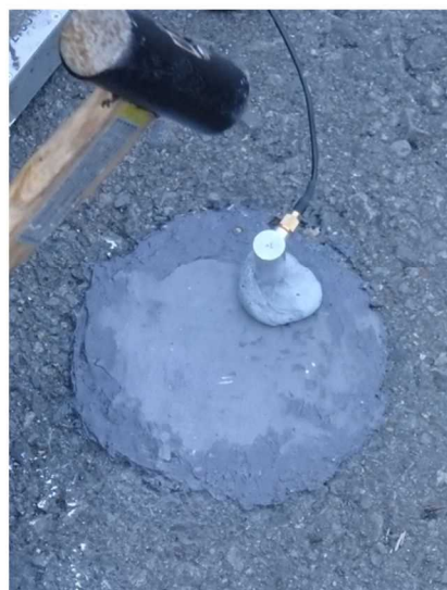
金属補修剤で補強した面での計測
