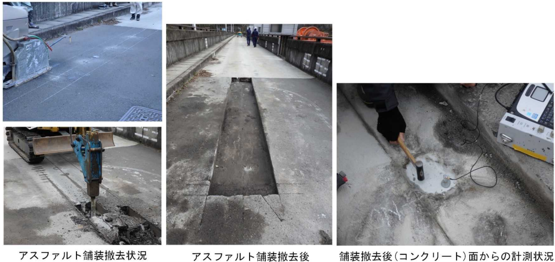
図-4.7.23 アスファルト舗装撤去状況と堤体コンクリート面からの計測状況
