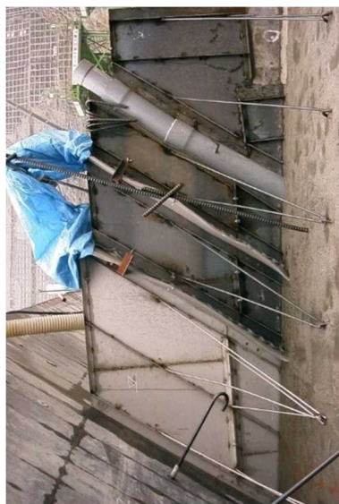
図-3.3.8 横継目止水板設置状況 9)
