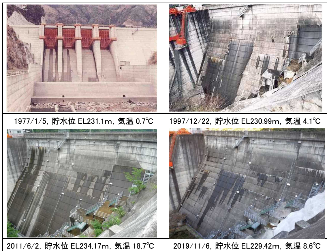
図-3.3.10 堤体下流面の漏水状況写真
