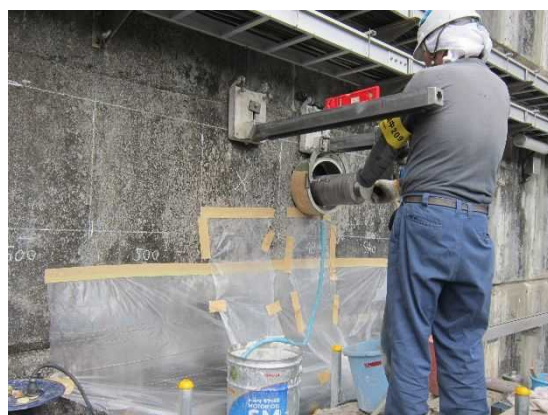
図-3.4.2(2) 堤体下流面からの ボーリング調査の実施状況事例
