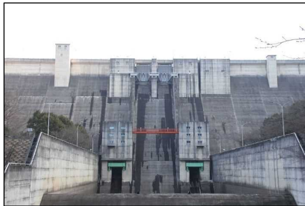
図-3.3.12 堤体下流面の漏水状況 (2013/1/31)
