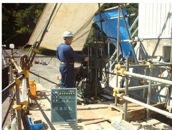
図-3.4.2(1) 堤体天端からの ボーリング調査の実施状況事例
