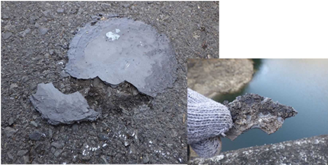
図-4.7.21 計測実施後の金属補修剤の撤去後状況
