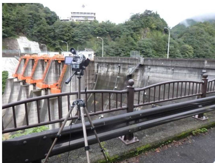
図-5.2.6 計測対象（Aダム下流面）と撮影位置との関係
