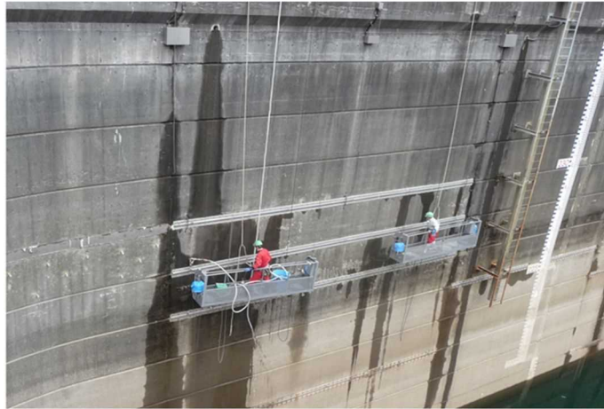
図-6.3.2 堤体上流面からの注入作業状況の事例(ゴンドラからの作業)
