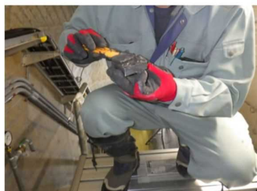
アタッチメント への補修剤塗布
