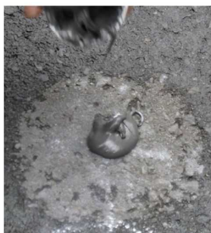
金属補修剤の塗布（舗装面の補強）状況
