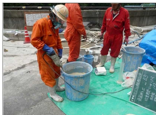
図-6.3.4 注入材の混合の状況例
