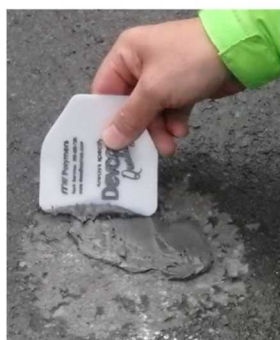
金属補修剤の塗布（舗装面の補強）状況
