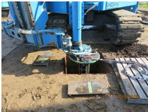
(g) 杭の施工状況
