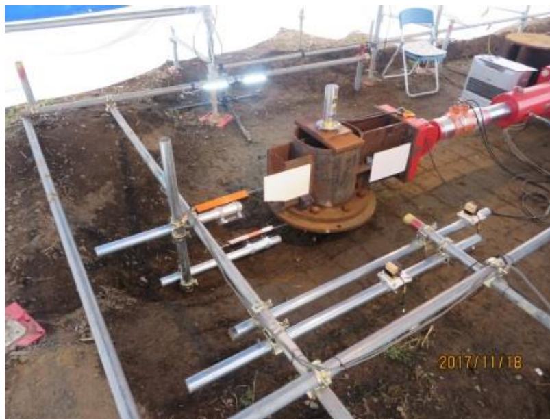
写真 2.6 载荷実験状況
