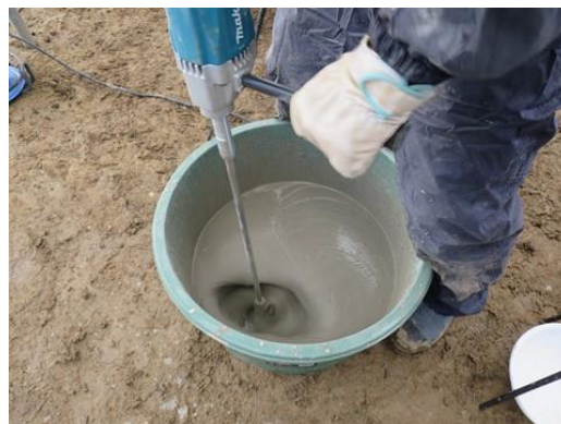
(b) 無収縮モルタルの攪拌状況
