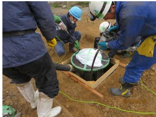
(j) 改良材の充填状況
