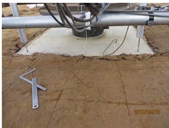
写真 4.6 改良体の鉛直変位の計測状況
