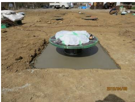
(k) 改良材の充填完了
