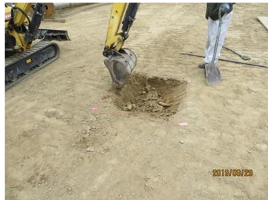
(b) 重機による改良領域の粗掘削
