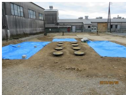
(l) 改良材充填後の養生状況
