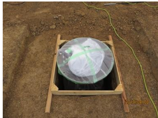
(h) 改良材充填前の型枠設置状況
