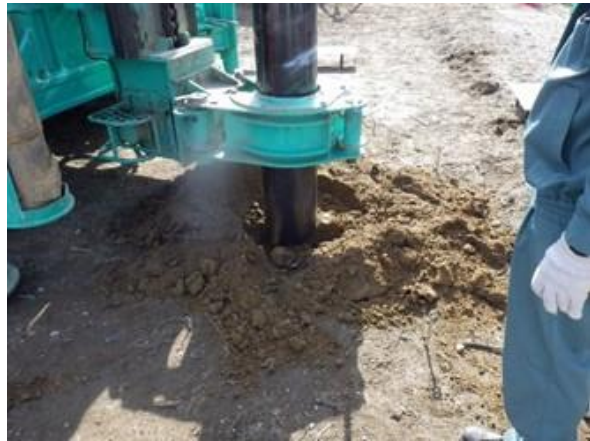
写真 1.1 羽根付き鋼管杭の施工時の状況
