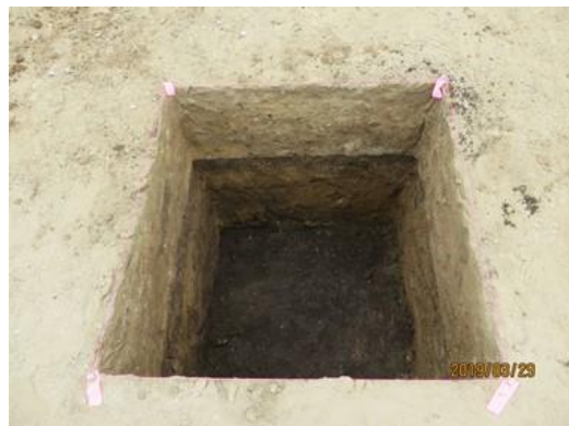
(f) 改良領域の掘削完了
