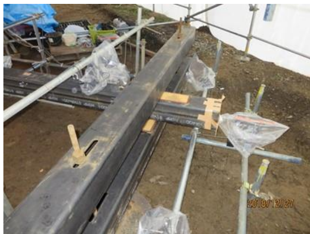
写真 3.7 固定梁の先端状況
