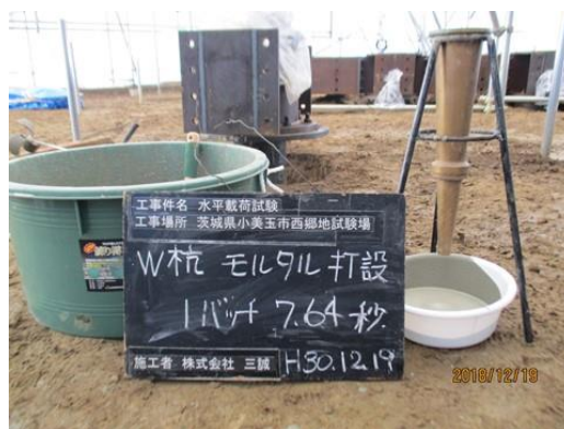
(d) 無収縮モルタルの材料試験
