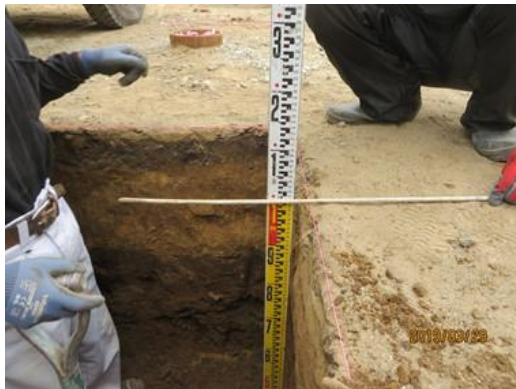
(c) 手掘りによる掘削孔の成形
