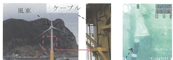
図8 浮体式風車へのケーブル布設状況
