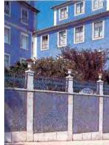
アズレージョによる正面扉外壁。 マルケス・デ・アブランテス通り、リスボン、19世紀後半。 写真：ニコラス・レモニエール
