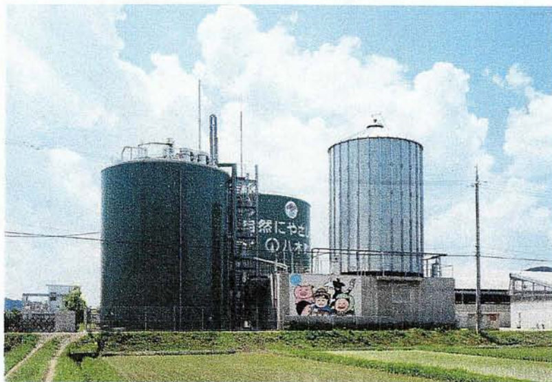
図 5.1.2 メタン発酵施設の外観写真
