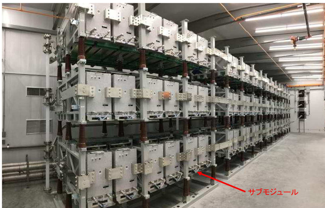
図 2 - 32 変換器室内変換器バルブ
